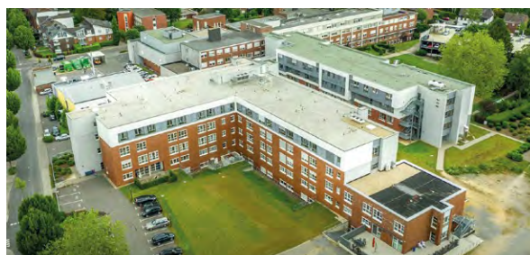
Das Hermann-Josef-Krankenhaus in Erkelenz erzeugt einen großen Teil seines Energiebedarfs im eigenen BHKW.
